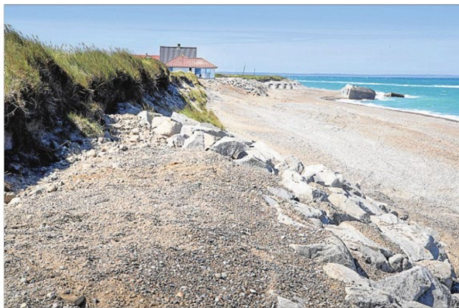
De 142 meter privat kystsikring ligger på begge sider af en kommunal grund, 50 meter øst for den og 92 meter vest for den. Nu arbejdes for at sikre de 143 meter midt imellem. Arkivfoto: Peter Mørk
